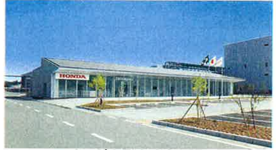
ホンダ寄居完成車工場
