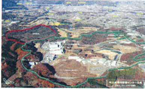
埼玉県環境整備センター
